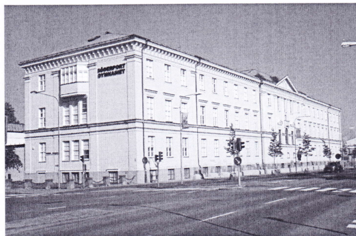
Söderport gymnasiet i Kristianstad, opført 1875 i kasernekvartæret
